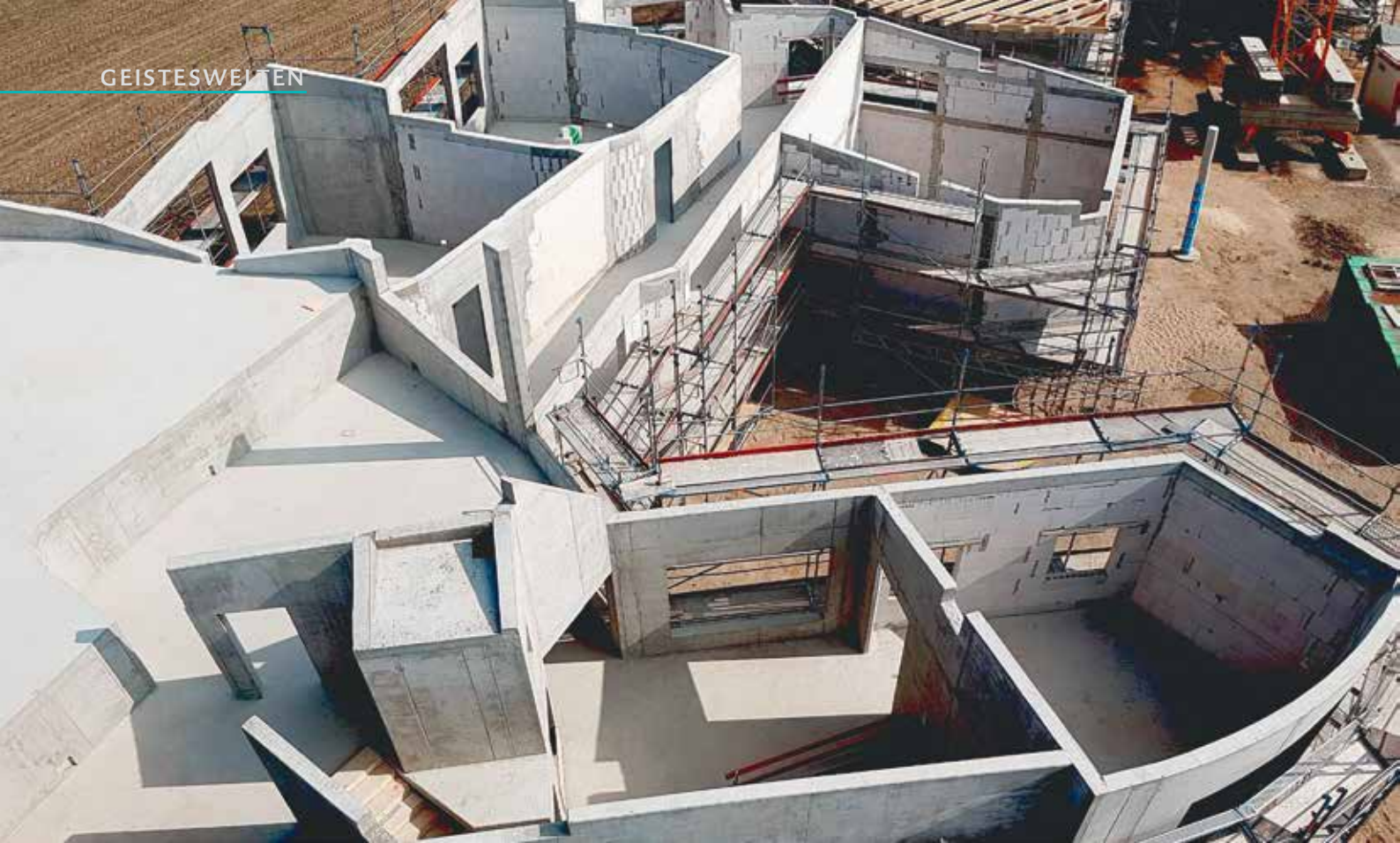
Ein Erweiterungsbau mit Pneumatit: Parzival Zentrum in Karlsruhe, eine für seine Notfallpädagogik bekannte Inklusionsschule. Architektin: Elke Schmitter, Stuttgart. (Bild von der ausführenden Baufirma Weisenburger GmbH, Rastatt)
